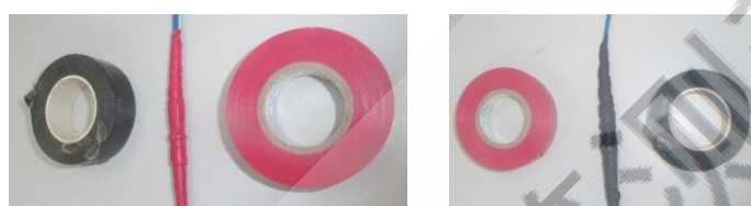
图 5.11.4-2 接头部位电工胶布包裹图接头部位防水胶布包裹
