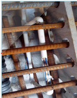
图 4.2.1-1: 需振捣混凝土内部植入保护
