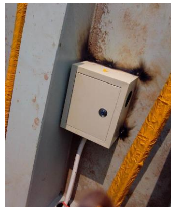
图 5.6-2 伸出混凝土部分光缆保护
