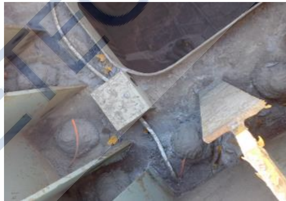
图 5.4-1 光缆和端头保护
